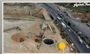
ورید دستگاه حفار مکانیزه TBM به شفت کن (شاتره)
